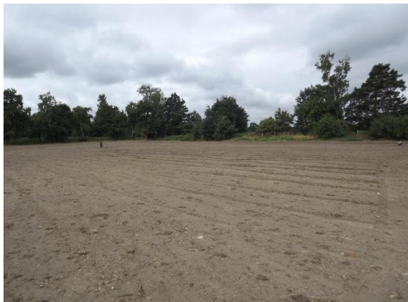
Składowisko odpadów w Stradomi Dolnej (widok po rekultywacji) lipiec 2013
